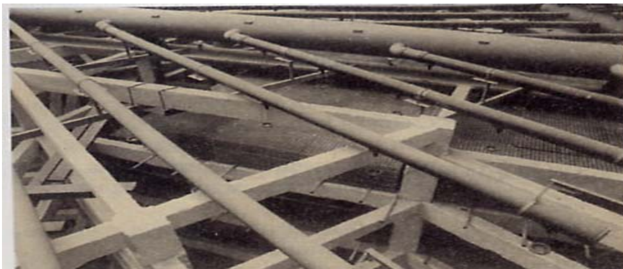
Рис. 14.9. Система водораспределения в градирне с распылением вниз
